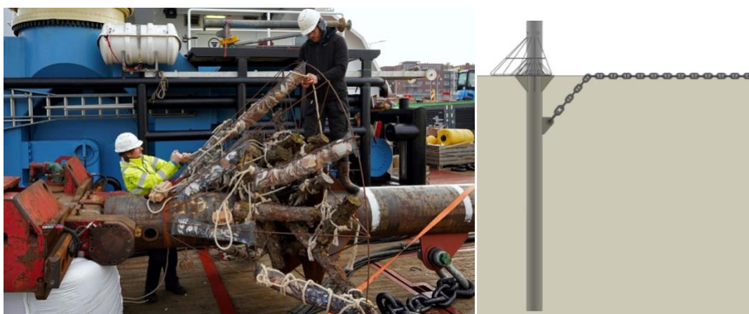
Figuur 6: Impressie eco-anker tijdens afbouw van de eco-structuur (links) en dwarsdoorsnede eco-anker met ankerketting (rechts) als onderdeel van een pilot met deze eco-ankers op de North Sea Farmers Offshore Test Site februari 2022
