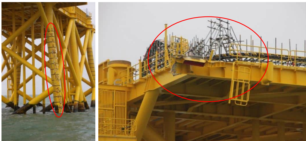
Afbeelding 3 : Schade aan onderstel TenneT-transformatorplatform na aanvaring Julietta D.
