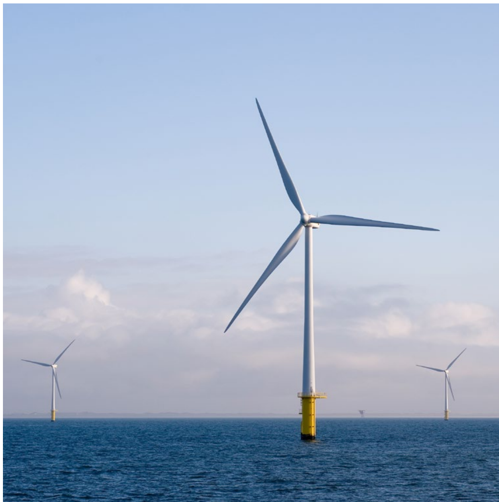
Offshore Windpark Egmond aan Zee.
