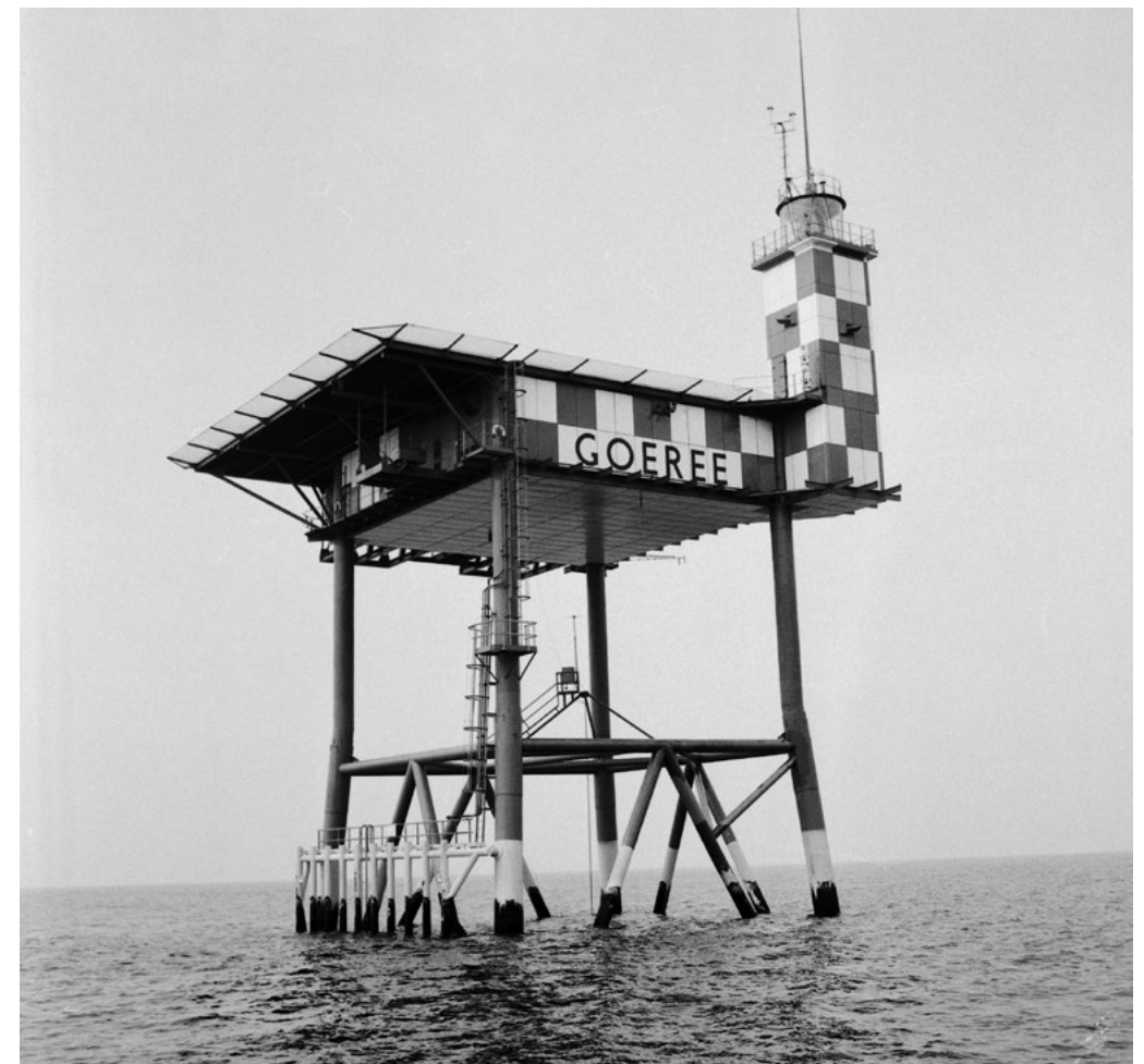
Op de Noordzee zijn door Rijkswaterstaat boeien uitgezet die onder andere golfhogtes registreerden. Het signaal wordt via lichteilanden als Goeree doorgestuurd naar de wal. 1972.
