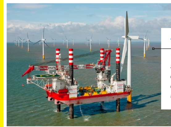
De bouw van een windmolenpark.
