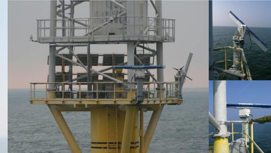
combinatie van horizontale S-band radar en verticale X-band radar
