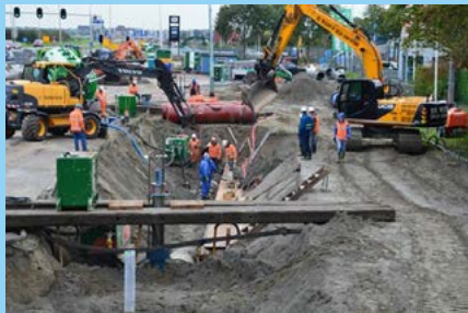
Omschakelen van oude naar nieuwe leiding
