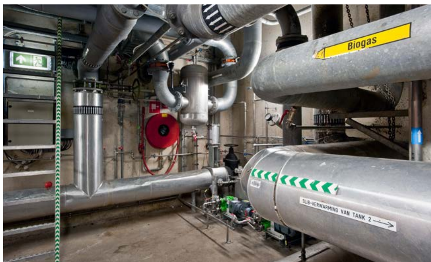
Installatie van de energiefabriek in Hengelo
