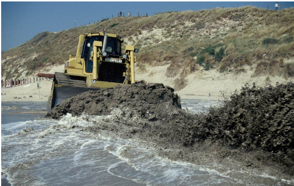
Foto 6.3. Werkzaamheden strandsuppletie. (Foto RWS)
