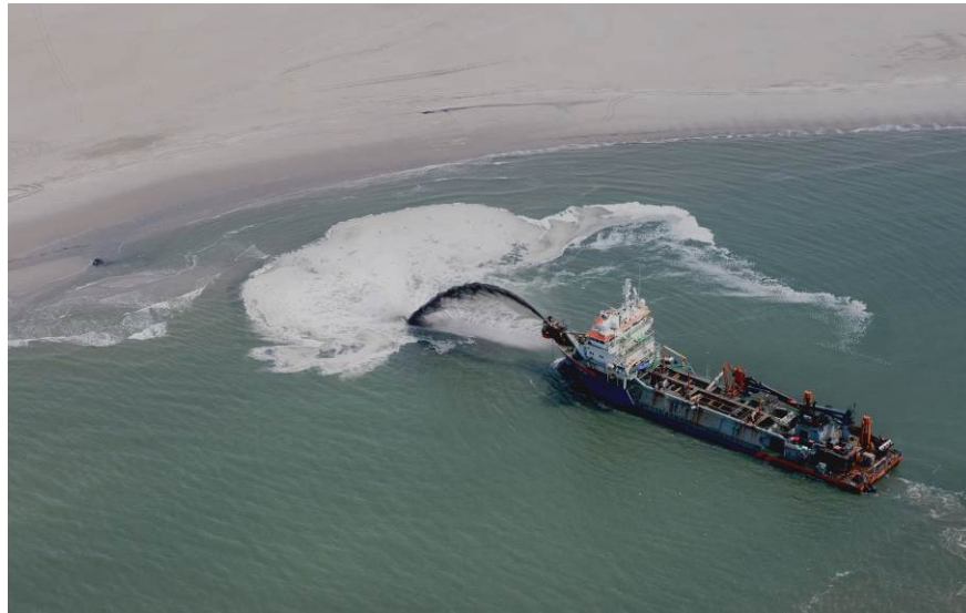
Foto 2.5. Kustbescherming door zandsuppletie. (Foto Joop van Houdt)
