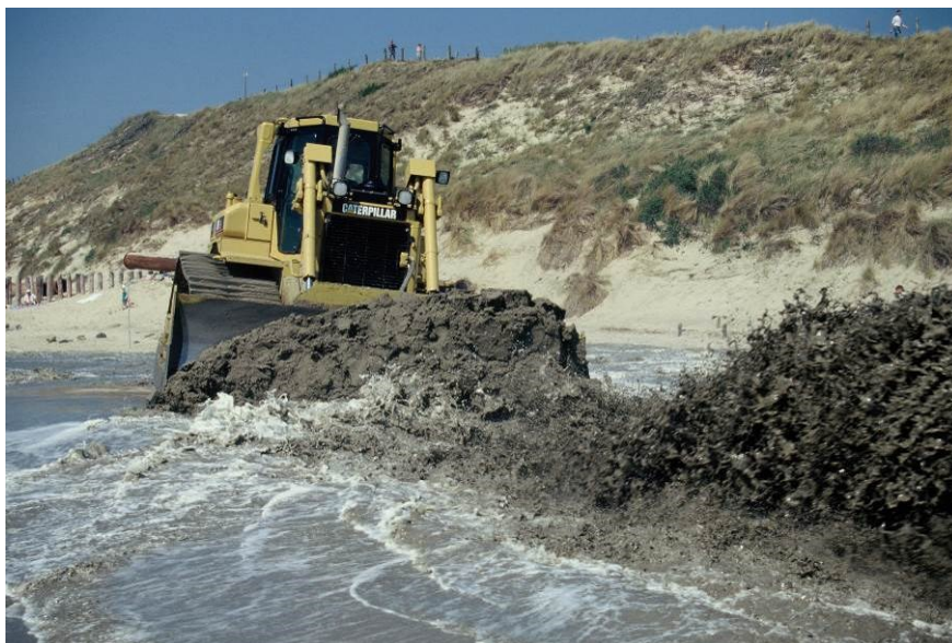
Foto 6.3. Werkzaamheden strandsuppletie. (Foto RWS)
