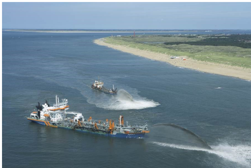
Foto 6.4. Onderwatersuppletie via 'rainbowen'. (Foto RWS)
