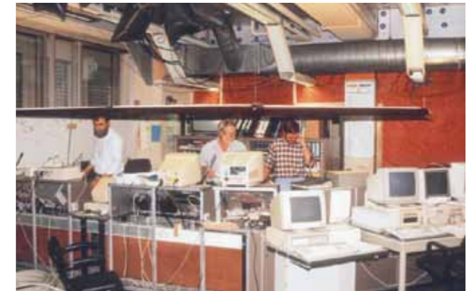
Verbouwing KWC IJmuiden 1992 (Foto: Peter Verburg)
